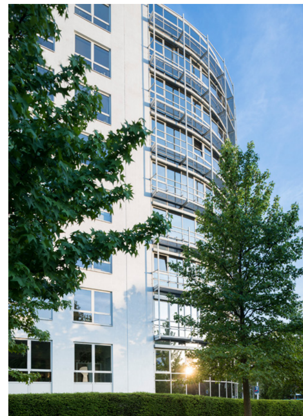
Das Riebeck No 51 besticht durch seine außergewöhnliche Fassade im Herzen der grünen Saalestadt.
